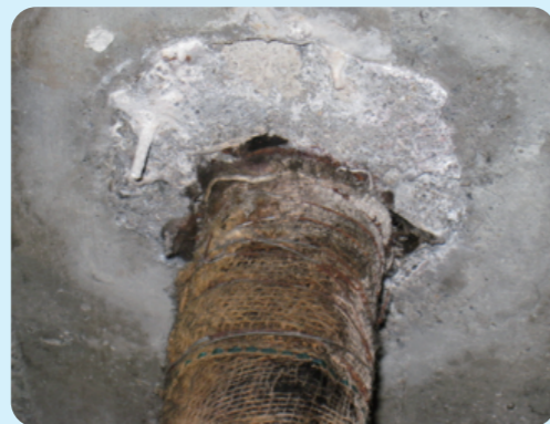
写真2：浴室下漏水配管用炭素鋼鋼管の全面腐食
